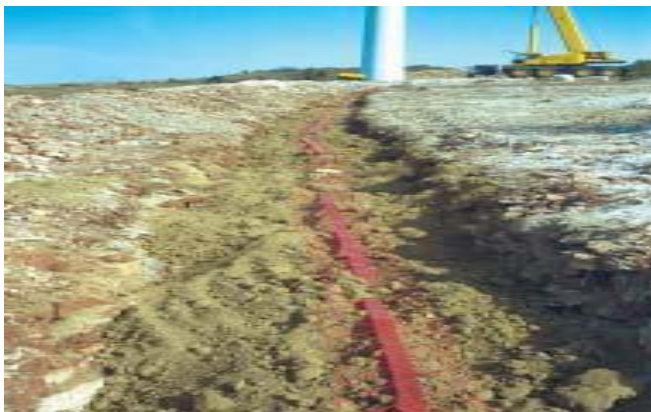
Фиг. 2.1-2. Траншея за подземните кабели
