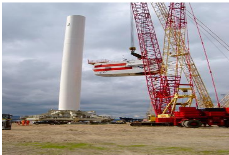
Фиг. 2.1-4. Монтаж на елементи на ветрогенератора
