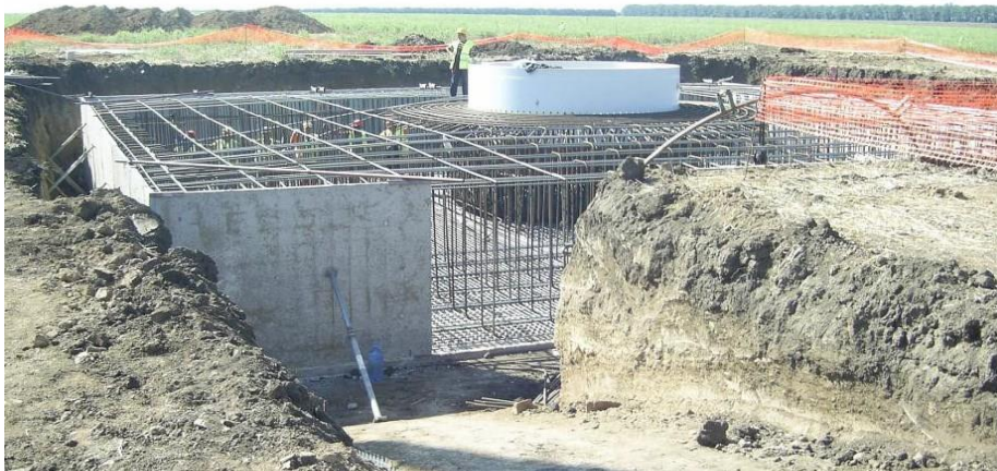
Фиг. 2.1-6. Котражни, бетонови и армивъчни работи по фундамента на ветрогенератора
