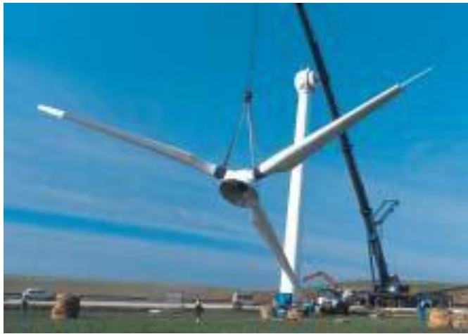
Фиг. 2.1.-1 Монтаж на ротора
