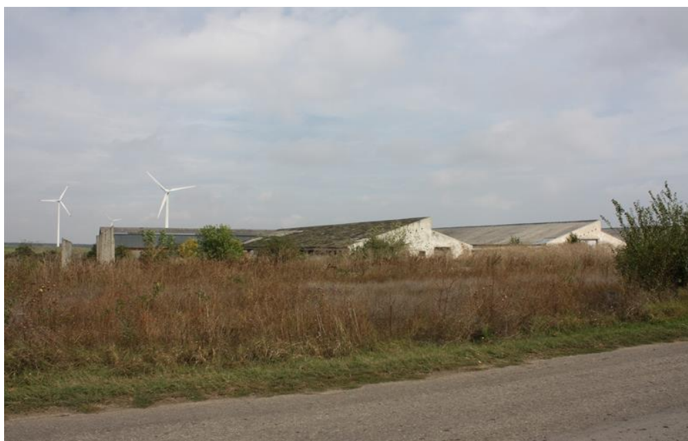
Фиг. №5.5. Изоставени промишлени постройки в близост до района на ИП.
